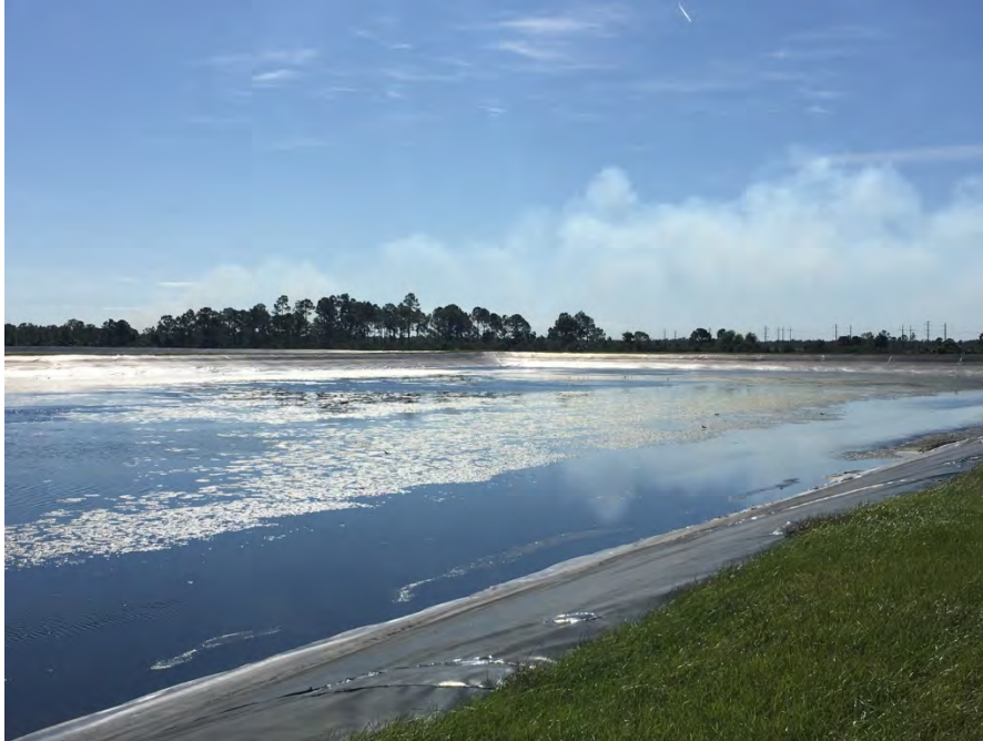
Figure 5-8 Punta Gorda WWTP – Holding Pond
